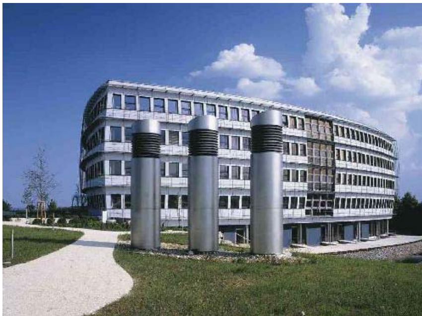
Energon , l'edificio passivo al momento più grande in Germania
